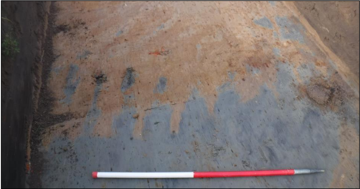
Figuur 19: Aanwijzingen voor verstoringen en uitgravingen (boven: compactie door rupsbanden, beneden: uitgravingen met getande bak)
