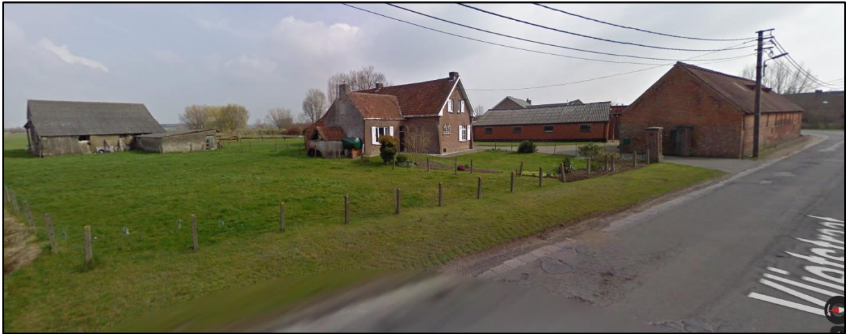
Figuur 2 Beeld op het plangebied vanuit het westen, met van links naar rechts: overdekte opslagplaats in de noordelijke hoek, vrijstaande woning, schuur dwars op de straat (recent afgebroken, niet meer aanwezig op figuur 1), schuur aan en evenwijdig met de straat (bron: https://www.google.com/maps ).
