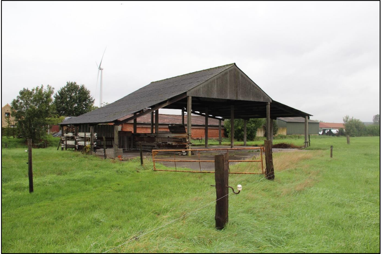
Figuur 4 Meer gedetailleerd zicht op de overdekte opslagplaats (bron: initiatiefnemer).
