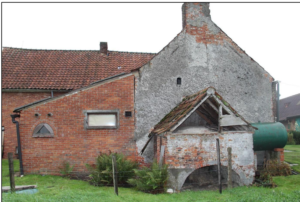
Figuur 9 Detail van de noordwestelijke gevel van de woning, met bakhuis tegen het oudste volume, en aanbouw links (bron: initiatiefnemer).
