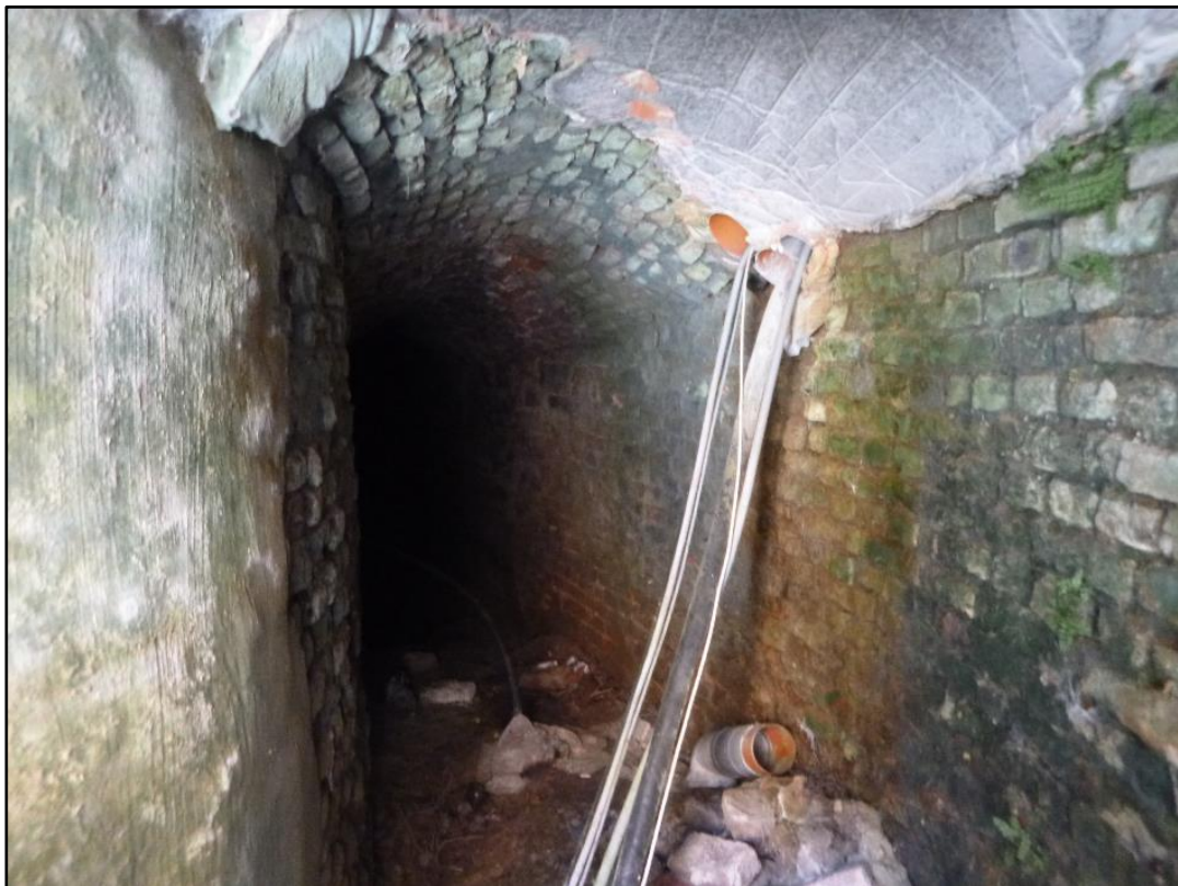
Figuur 27: Ondergrondse bakstenen gang (ABO nv 2019)
