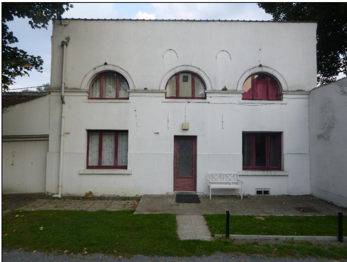
Figuur 19: Vooraanzicht van het oostelijke gebouw (ABO nv 2019)
