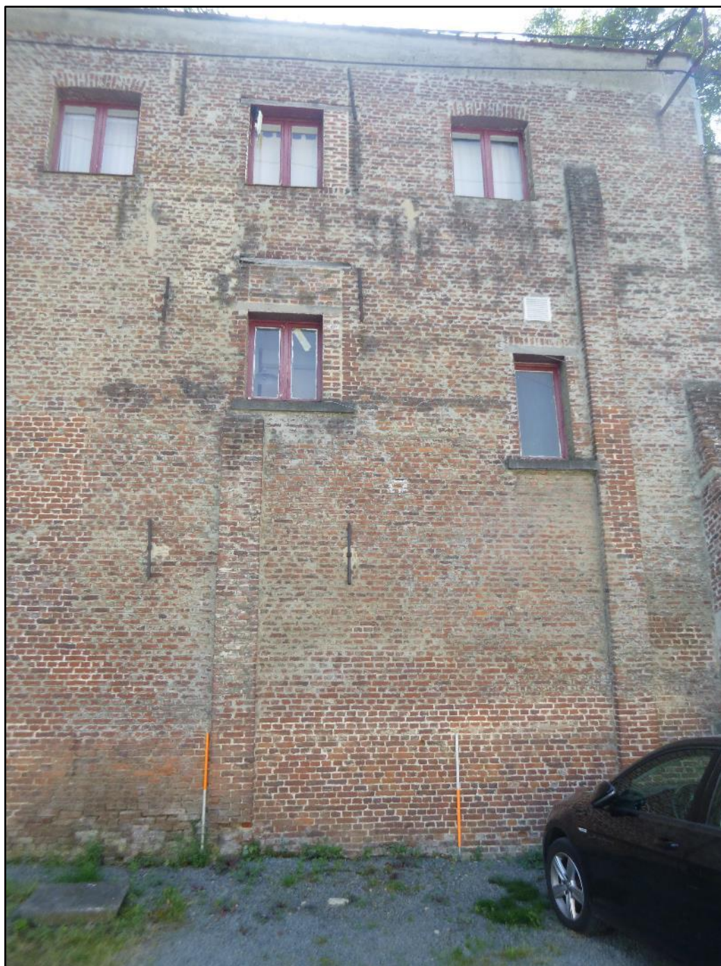
Figuur 24: Vooraanzicht op de buitenzijde van het oostelijke gebouw (ABO nv 2019)
