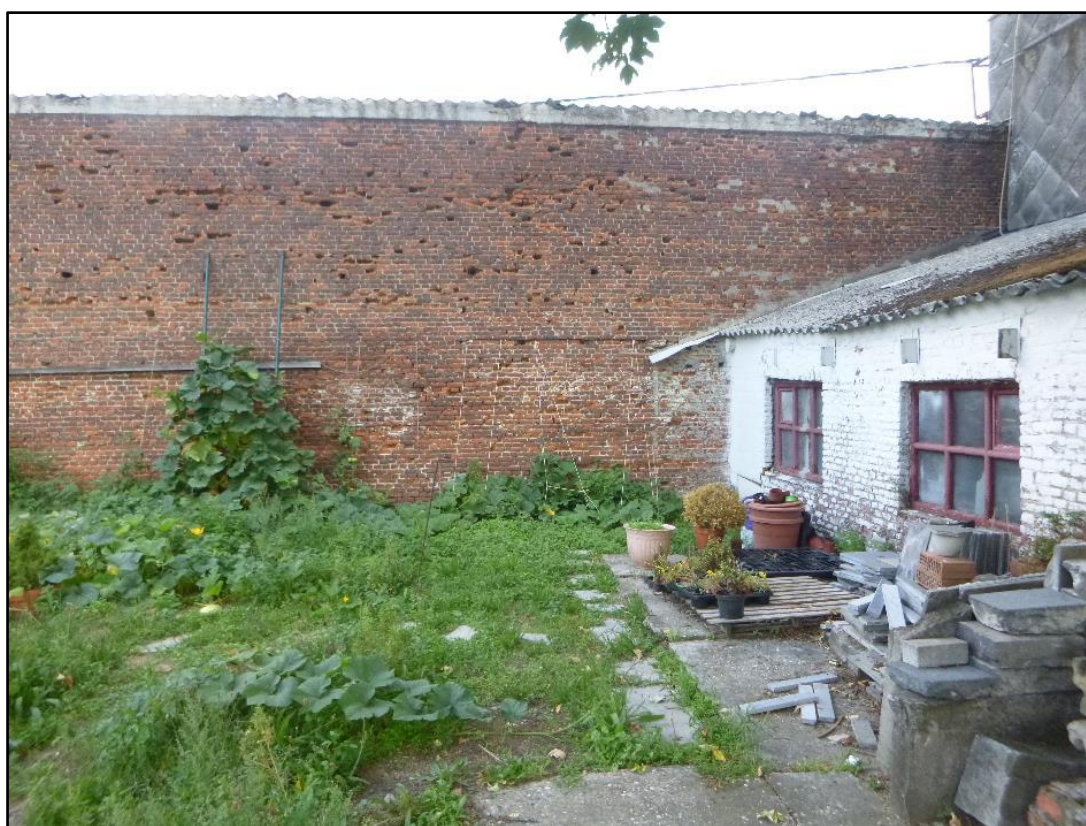
Figuur 21: Binnenzicht van de keermuur van de voormalige oostelijke serre (ABO nv 2019)
