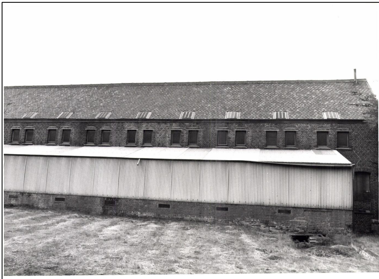
Figuur 31 Zicht op de constructiewerkplaats Van Lierde, gezien vanuit het oosten. De foto dateert van 19/07/1976 (bron: https://beeldbank.onroerendergoed.be/images/347385 ).
