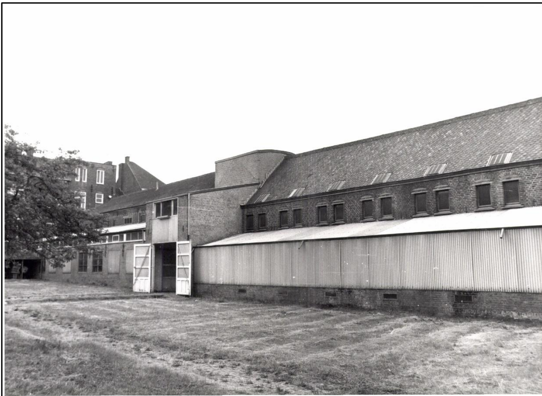
Figuur 30 Zicht op de constructiewerkplaats Van Lierde, gezien vanuit het noordoosten. De huizen op de achtergrond zijn de achtergevels van de woningen langs de Hospitaalstraat. De foto dateert van 19/07/1976 (bron: https://beeldbank.onroerendergoed.be/images/347382 ).
