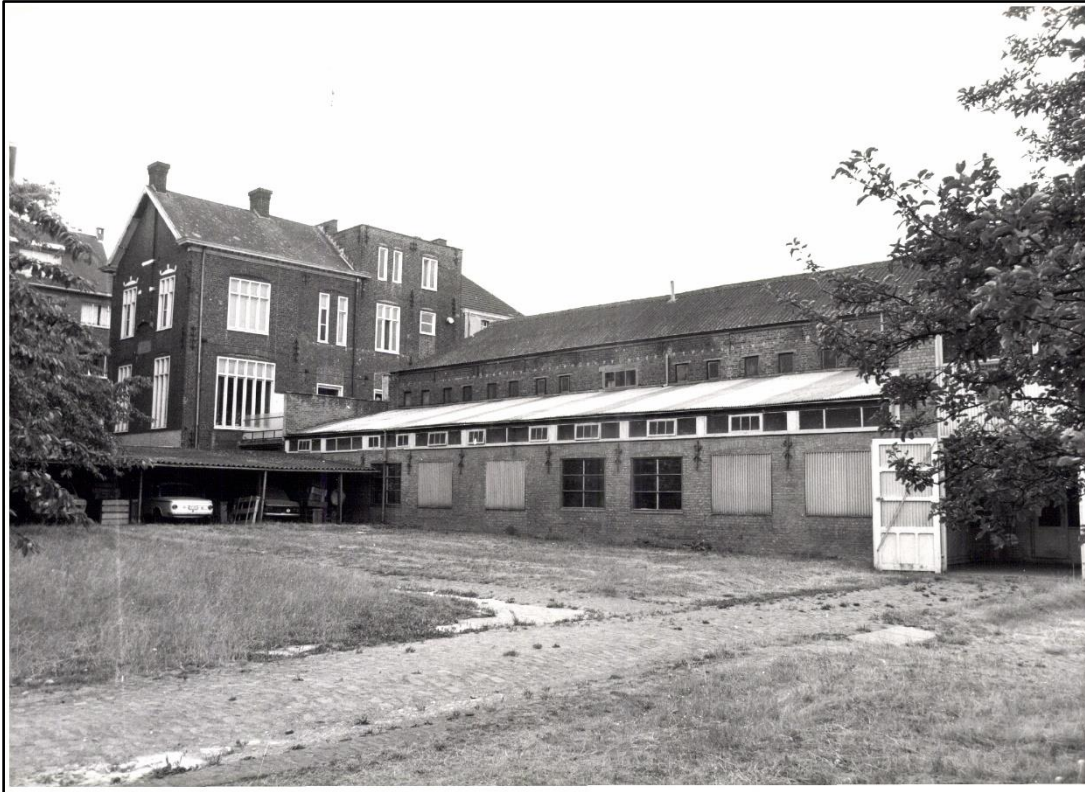
Figuur 29 Zicht op de constructiewerkplaats Van Lierde, gezien vanuit het noordoosten. De huizen op de achtergrond zijn de achtergevels van de woningen langs de Hospitaalstraat. De foto dateert van 19/07/1976 (bron: https://beeldbank.onroerendergoed.be/images/347383 ).
