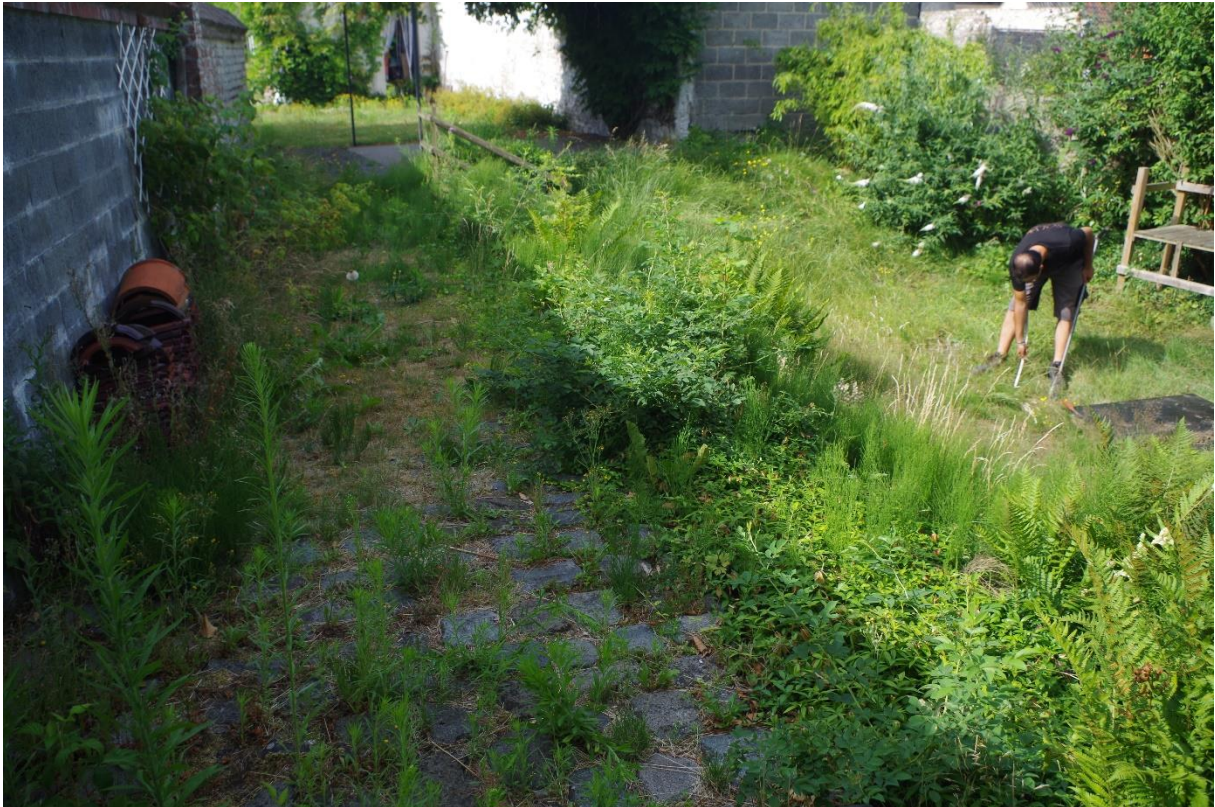
Foto 21 Bovenzicht op het talud tegen de kerkhofmuur.
