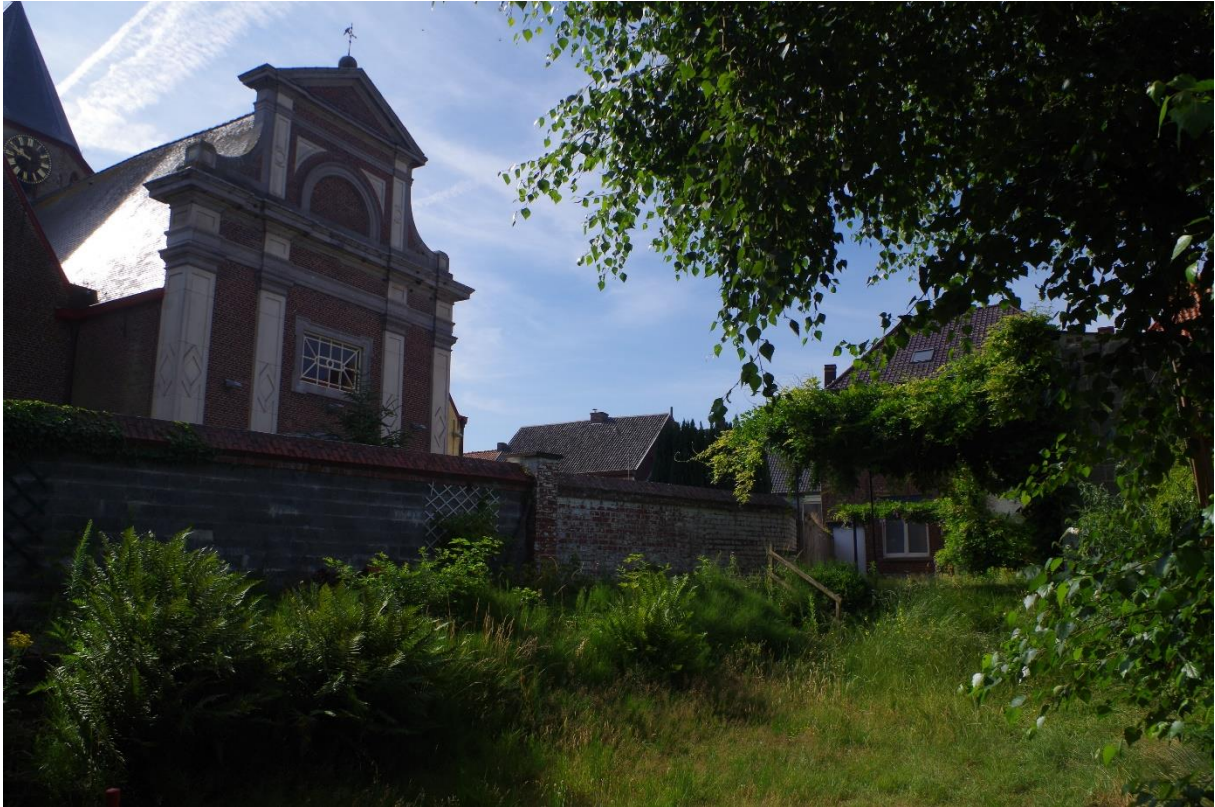
Foto 20 Zicht op de talud tegen de kerkhofmuur.
