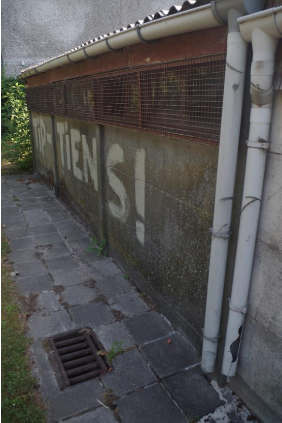
Foto 6 Bestaande infrastructuur met waterafvoer langsheen het sportveld
