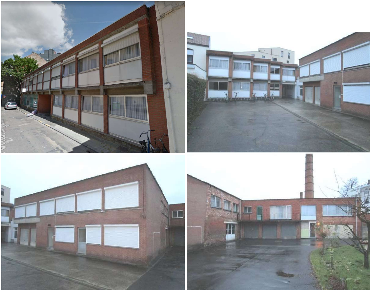
Figuur 4. Zicht op de bestaande structuren aan de Verkortingsstraat.
