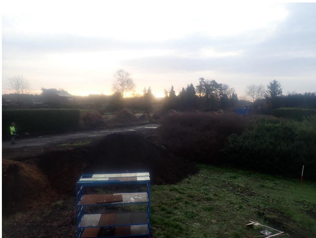
Figuur 23: Zicht op het terrein vanuit noordwestelijke richting (© J. Verrijckt Bvba)
