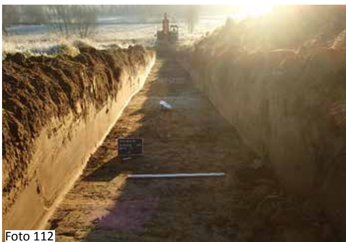
Figuur 112: Sleuf 11 aan de aanzet van het colluvium
