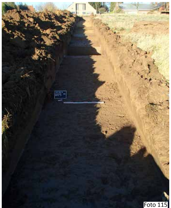
Figuur 115: Proefsleuf 13 vanuit het oosten gefotografeerd
