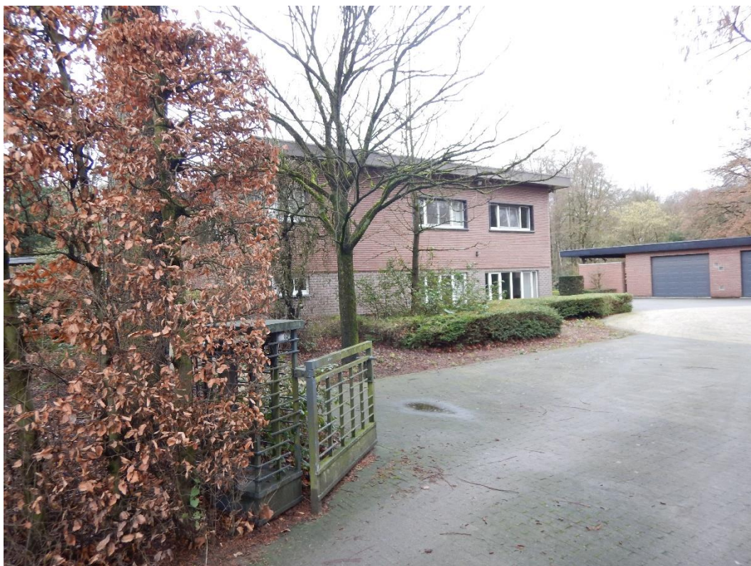
Fig. 26: de woning, noordgevel
