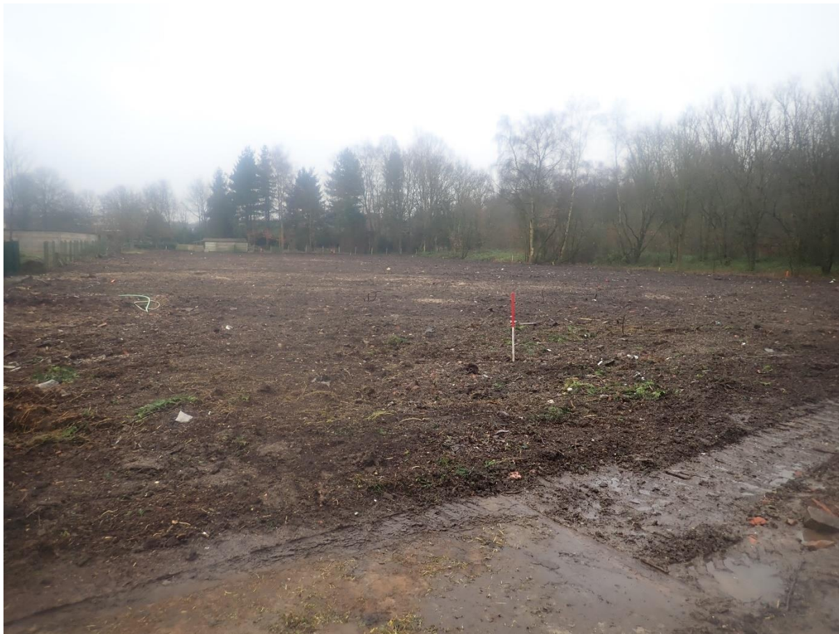
Figuur 4: Zicht op het terrein ter hoogte van het toekomstige bufferbekken (© J. Verrijckt Bvba).
