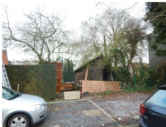
Fig. 26: detail van de zuidoostzijde van de parking en het nog af te breken “tuinhuis”
