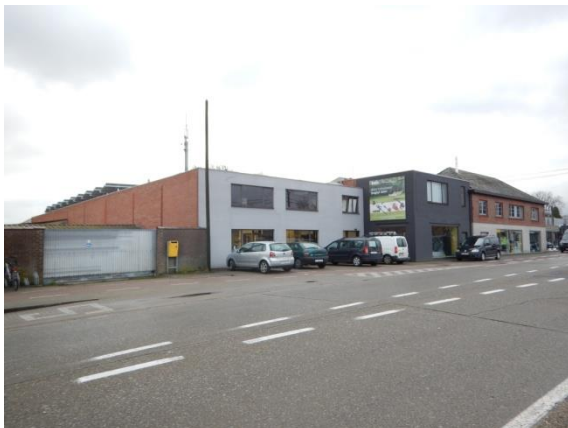
Fig. 23: zicht vanop de Steenweg op de bestaande gebouwen
