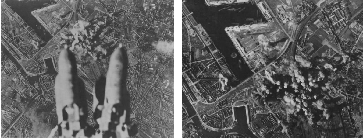
fig. 14: Het bombardement op rangeerstation Gent-Dampoort (22 juni 1944). 50
