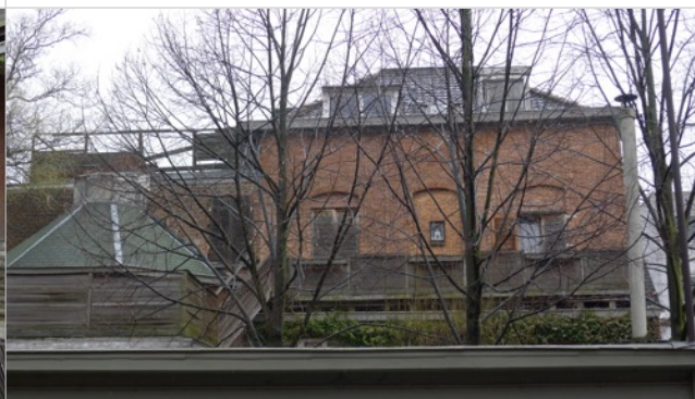
Foto 11: de achtergevel van het kantoorgebouw vanaf de garageboxen aan de Kistemaekersstraat.
