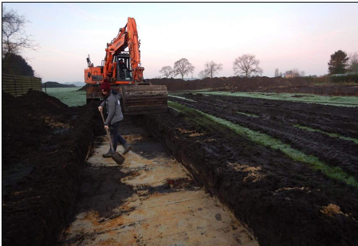
Figuur 10 Sfeerbeeld tijdens de aanleg van sleuf 1.
