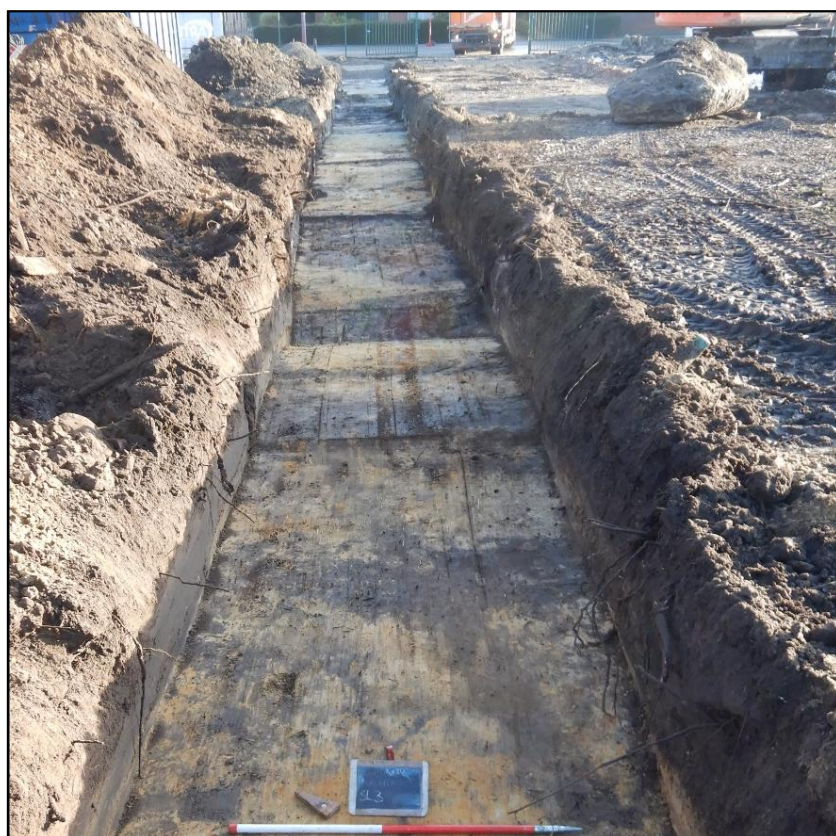
Figuur 21 Zicht op sleuf 3 vanuit het westen.
