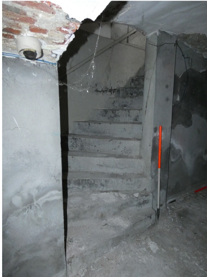
Figuur 32: westelijke muur (PRW) met detail trap (M5), kelder 1
