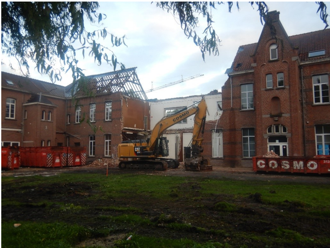
Figuur 10: Foto bestaande toestand (17/10/2019): sloop huidige bebouwing
