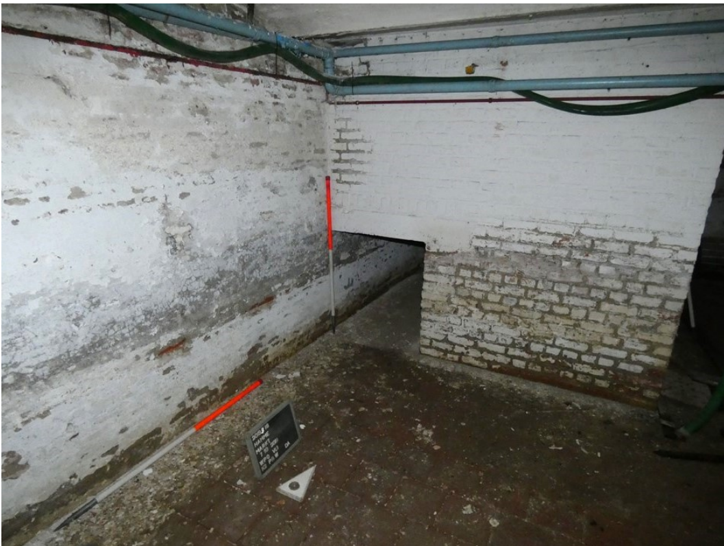
Figuur 37: westelijke muur (M7), met vloer (M6) en aanzet lift versteving (M10), kelder 2
