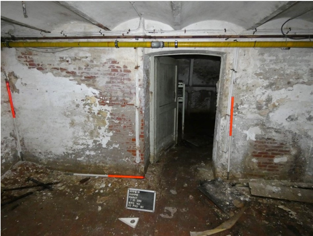
Figuur 34: oostelijke muur (M7) met aanzet troggewelf (M9) en met doorgang naar kelder 3, kelder 2
