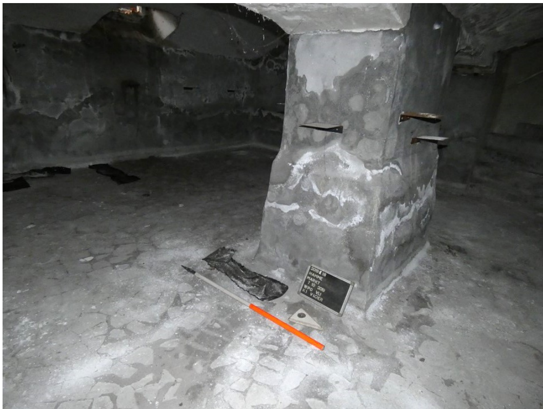
Figuur 33: vloer (M1) met steunbeer (M3) en aanzet gewelf (M4), kelder 1
