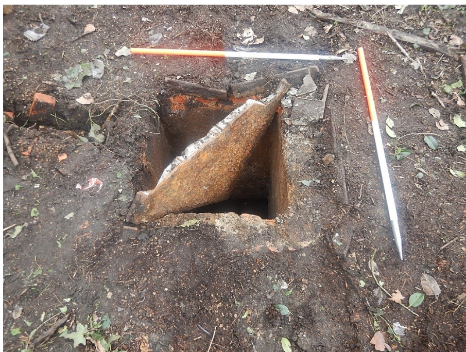
Figuur 57: Bovengronds mangat van de overwelfde Rijbeek
