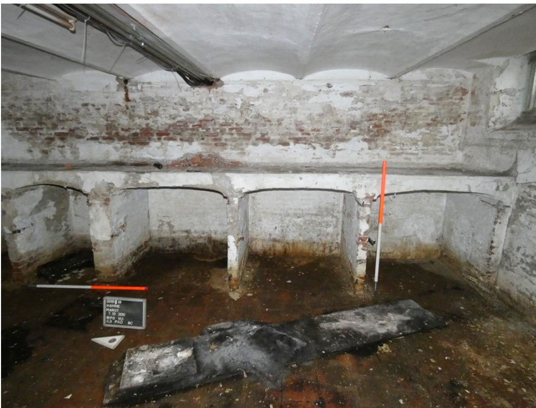
Figuur 35: oostelijke muur (M7) met aanzet troggewelf (M9) en voorraadvakjes (M8), kelder 3
