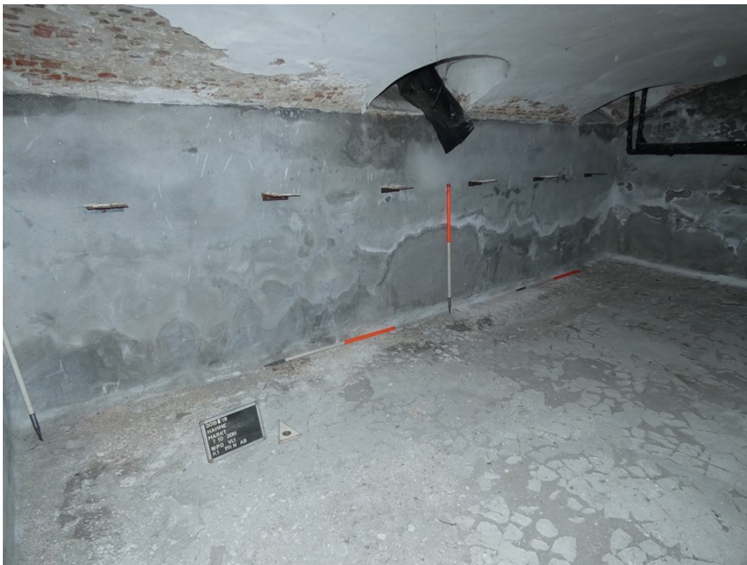
Figuur 31: noordelijke muur (PRN) met aanzet tongewelf (M4) en raam, kelder 1
