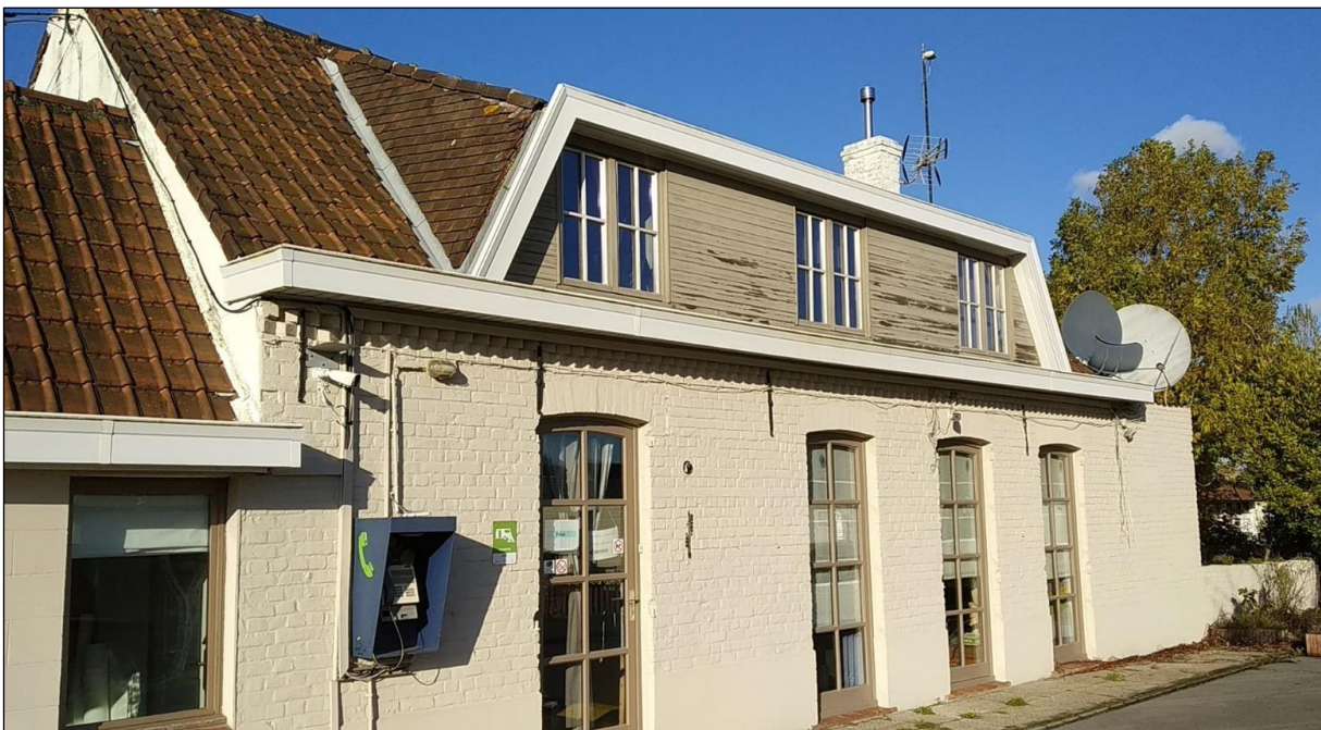
Figuur 26: Oostelijk deel van het gebouw.
