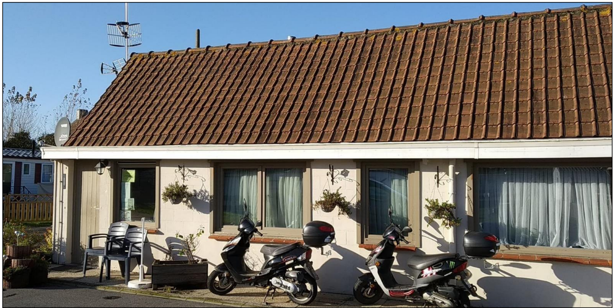
Figuur 27: westelijk deel van het gebouw.
