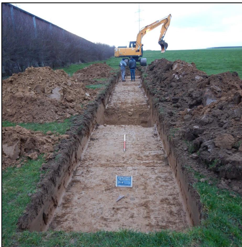
Figuur 6 Sfeerbeeld tijdens de aanleg van de sleuven.
