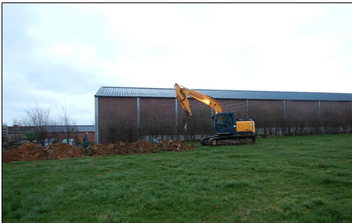
Figuur 5 Sfeerbeeld tijdens het uitvoeren van de proefsleuven met een duidelijk zicht op de hellingsgraad.
