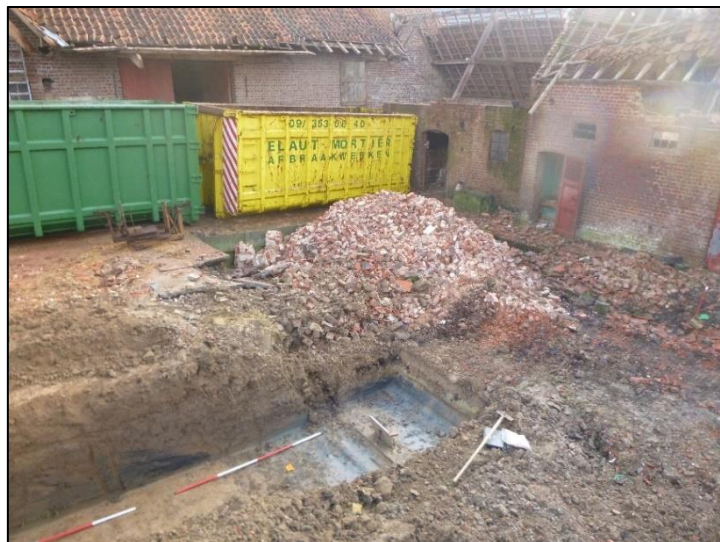
Figuur 13: Zicht op het zuiden van werkput 6, met S6001 als grijsblauwe verkleuring in het vlak en op de achtergrond de recente verdiepte mestkuil met betonnen wanden (op de foto volgestort met baksteenpuin van de afbraakwerken).
