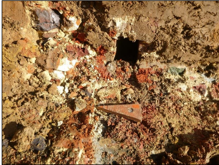
Figuur 25: Aansluiting van S2002/S6003 in de noordoostelijke hoek van de kelder van het voormalige woonhuis.
