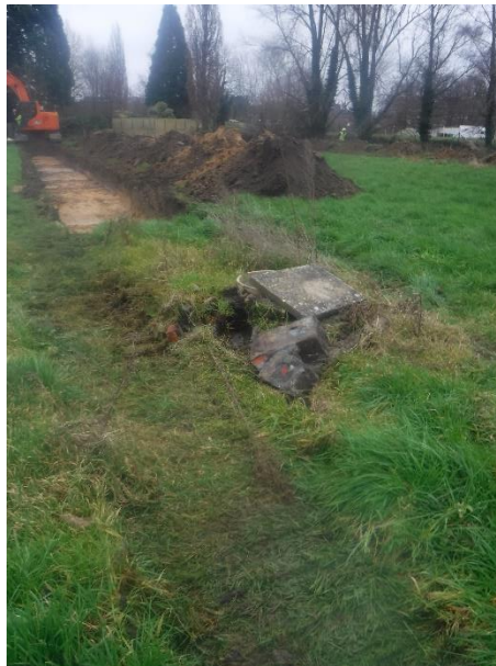
Figuur 9. Hindernissen: afbraak woning (boven), waterput op traject van werkput 4 (onder).
