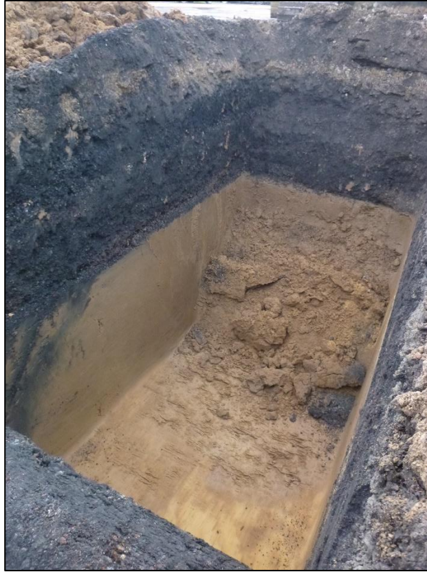
Figuur 27: Werkput 4, zuidelijke deel. Verdieping tot onder het colluvium
