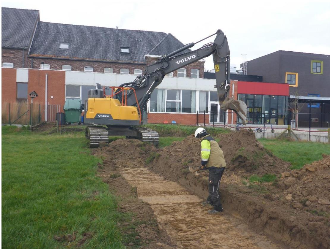
Figuur 9: Overzicht tijdens de werkzaamheden in werkput 1 (GATE).
