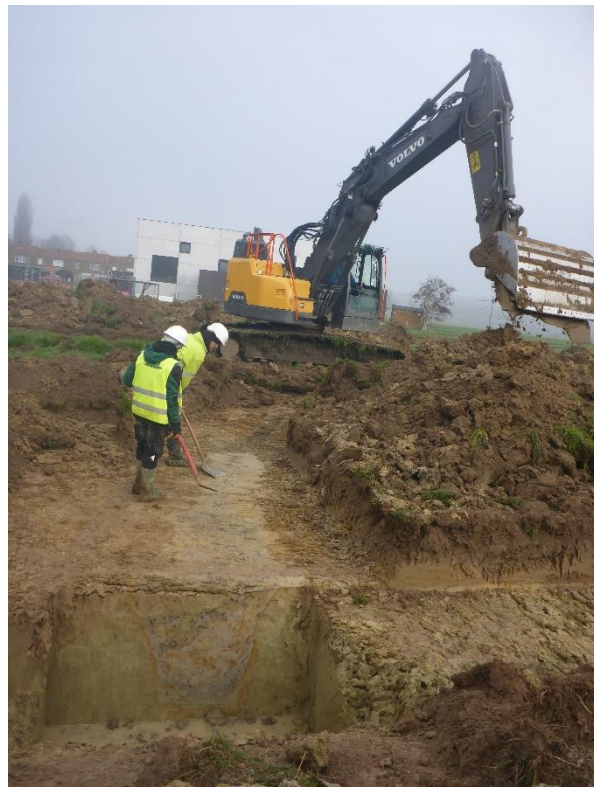
Figuur 8: Overzicht tijdens de aanleg van werkput 7 (GATE).
