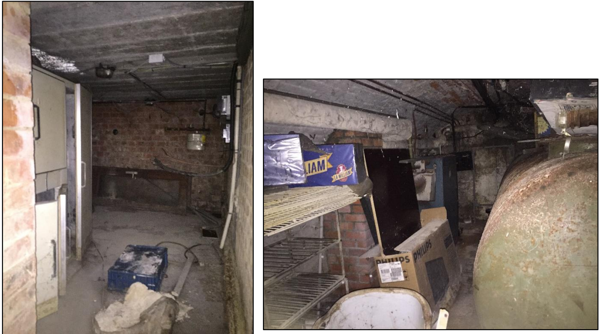
Afb. 33-34: recentere kelder van woning nr. 213 aan de Diestsestraat.
