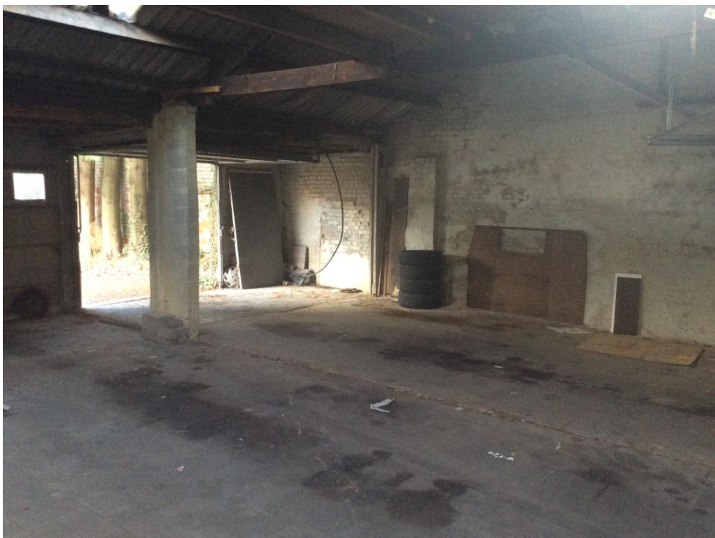
Foto 3: Zicht binnenin garage aan de Kaardeloodstraat.
