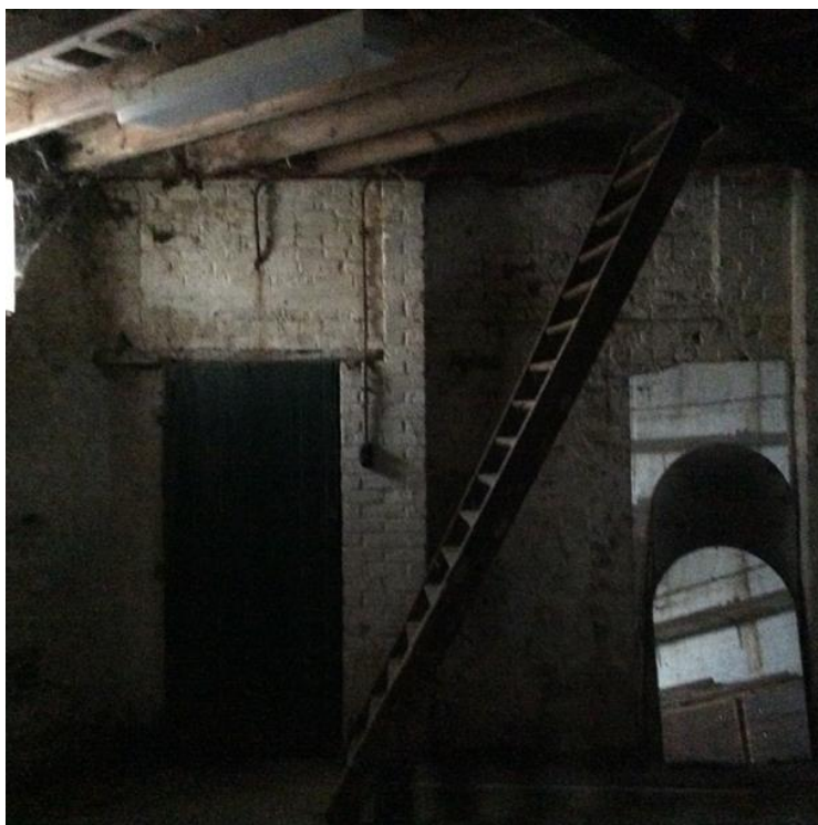
Foto 1: Kelder onder woning in de Beverstraat
