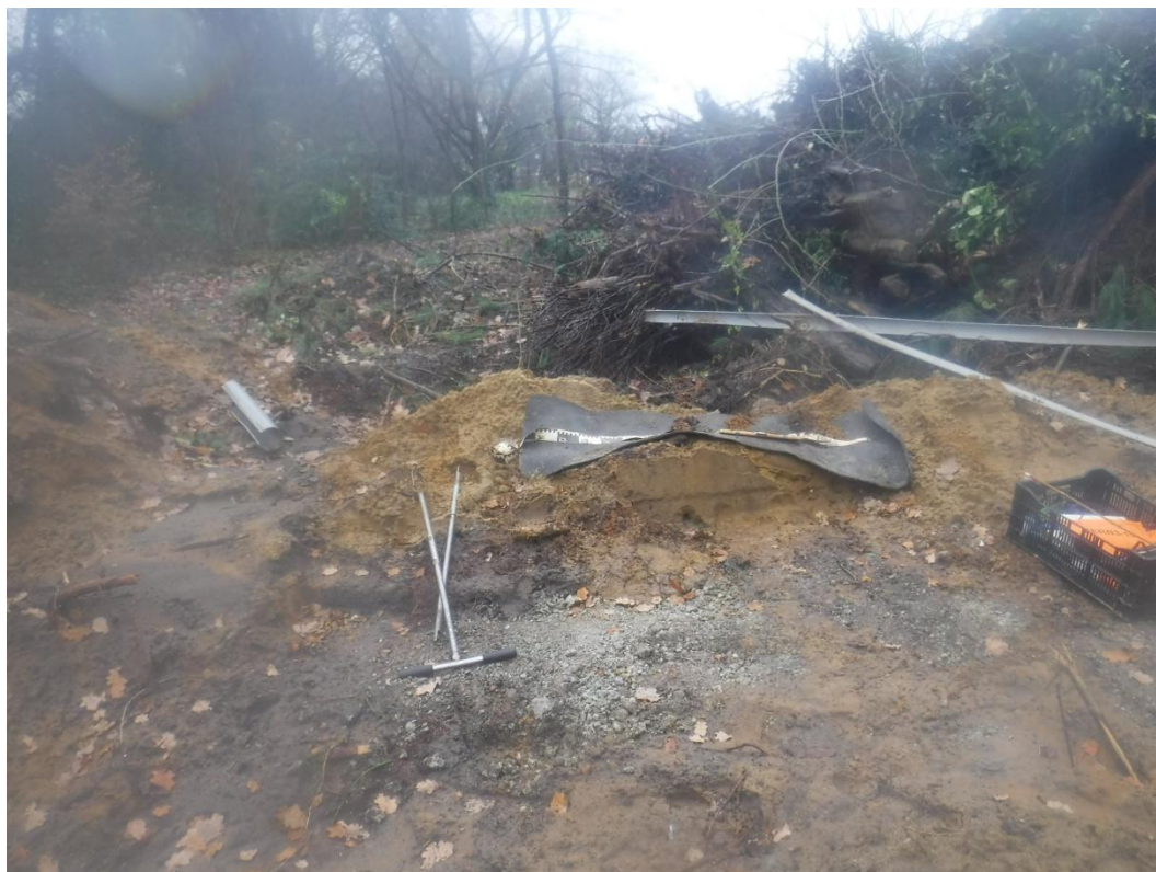
Afb. 7. Actuele situatie van het plangebied, gezien in noordelijke richting. Opnamedatum: 3 december 2019.
