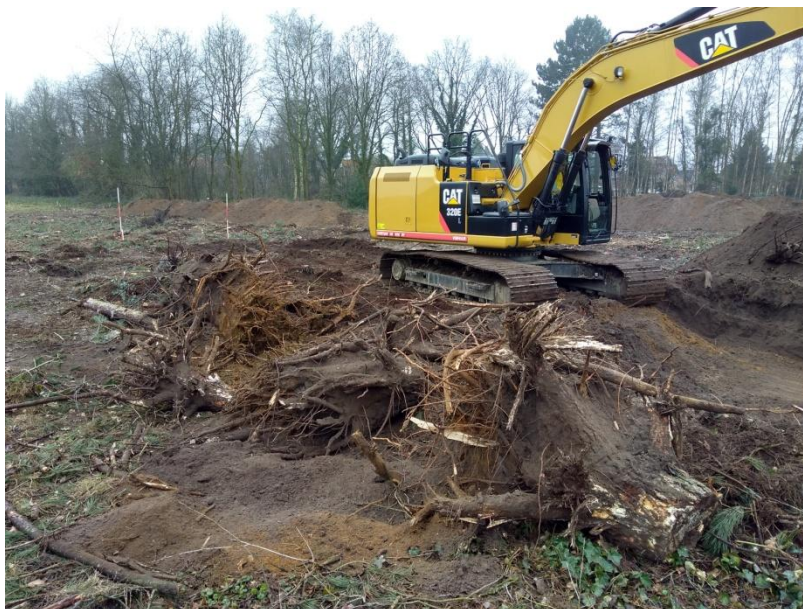
Afb. 15. De boomstronken uit de proefsleuf worden aan de kant gelegd.
