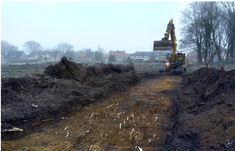
Afb. 23. Het volledige vlak van werkput 17 wordt ontsierd door boomwortels.
