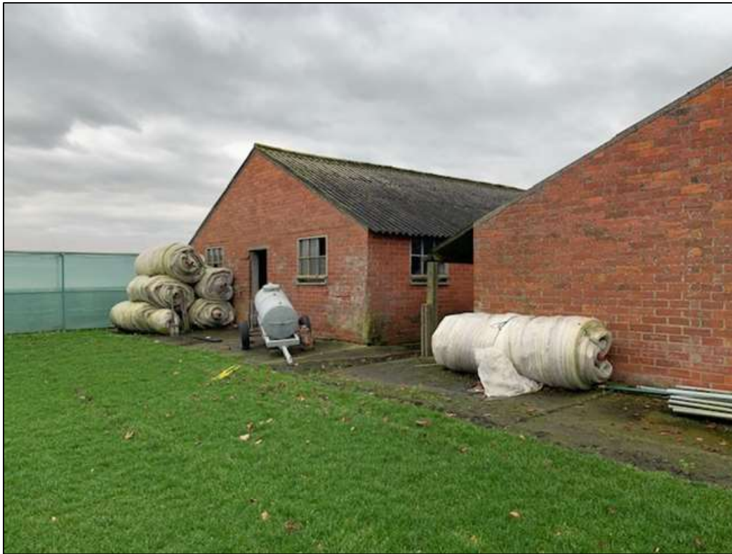
Figuur 8. Zicht op de te slopen structuren en verhardingen. ©LARES
