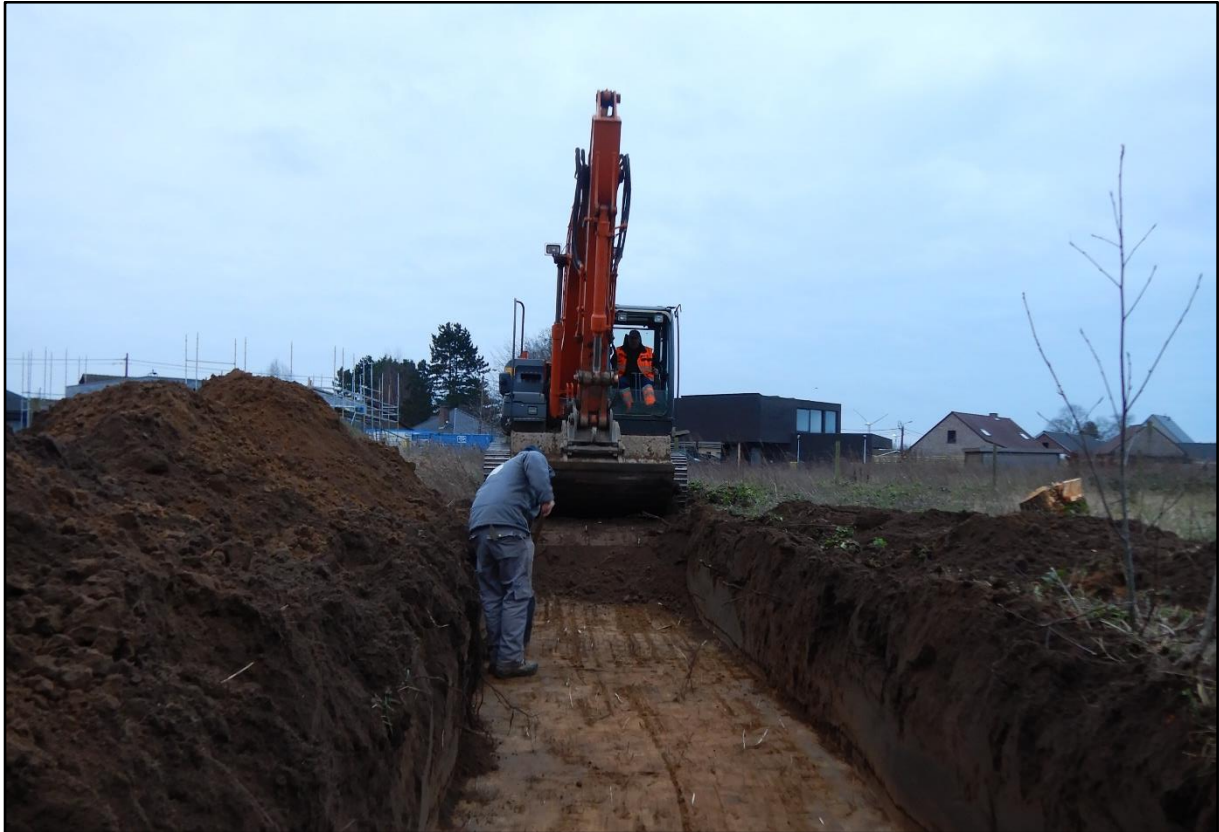
Figuur 5 Aanleg en opschaven van de proefsleuven.
