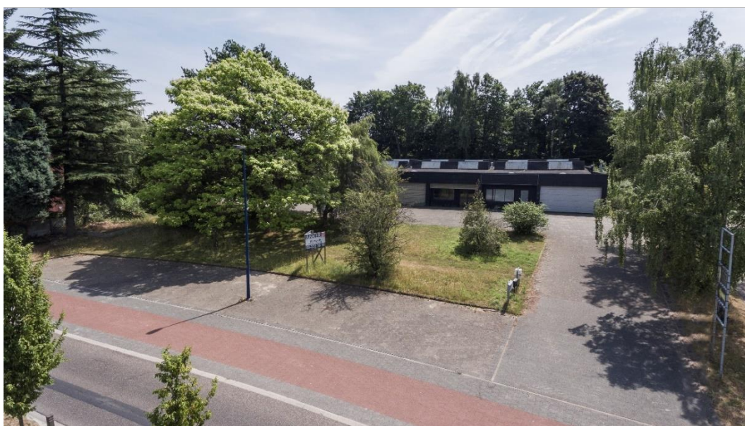
Figuur 5: Kantorengebouw aan de Pronkenbergstraat (APART real estate nv, 2017)
