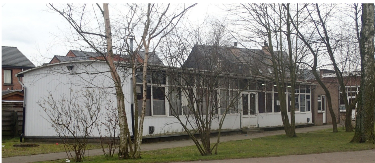
Fig. 28. Zicht op het zuidelijke gebouw aan de westzijde (foto Erfpunt).
