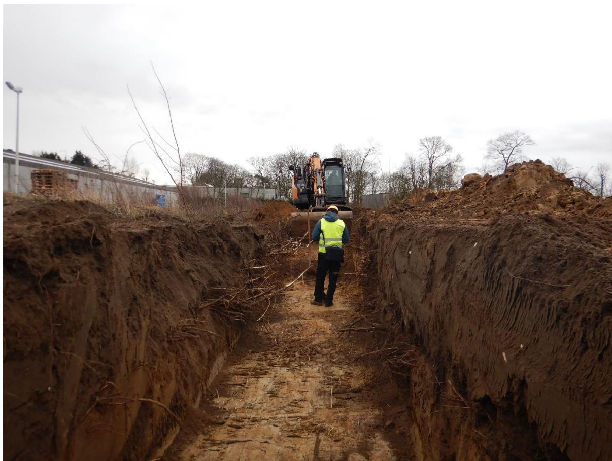
Figuur 4: Het uitgraven van sleuf 1.
