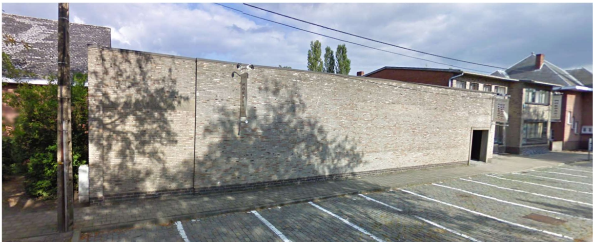
Figuur 5. Zicht op gebouw 2. © Google Streetview
