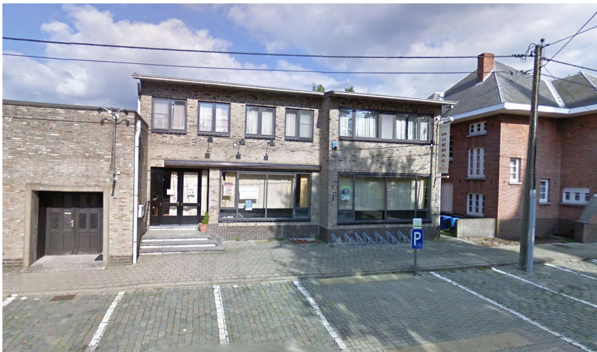
Figuur 6. Zicht op gebouw 3. © Google Streetview
