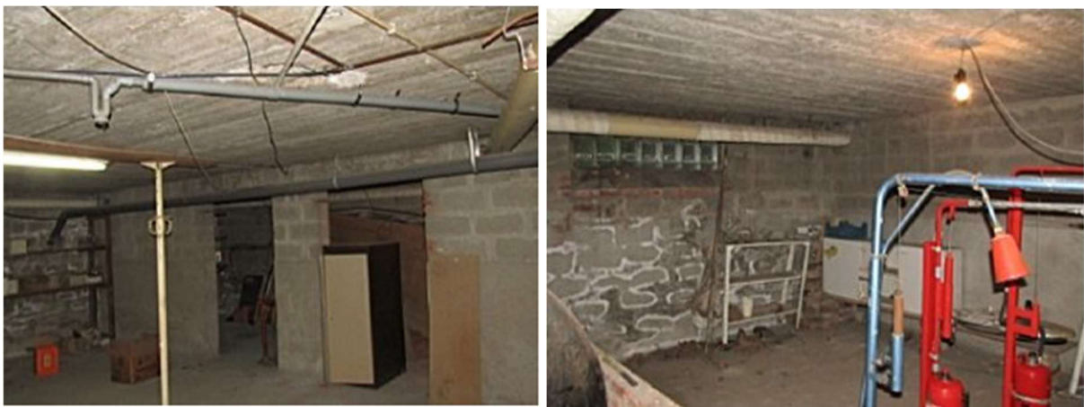
Figuur 4. Impressie van de kelder van gebouw 1.
