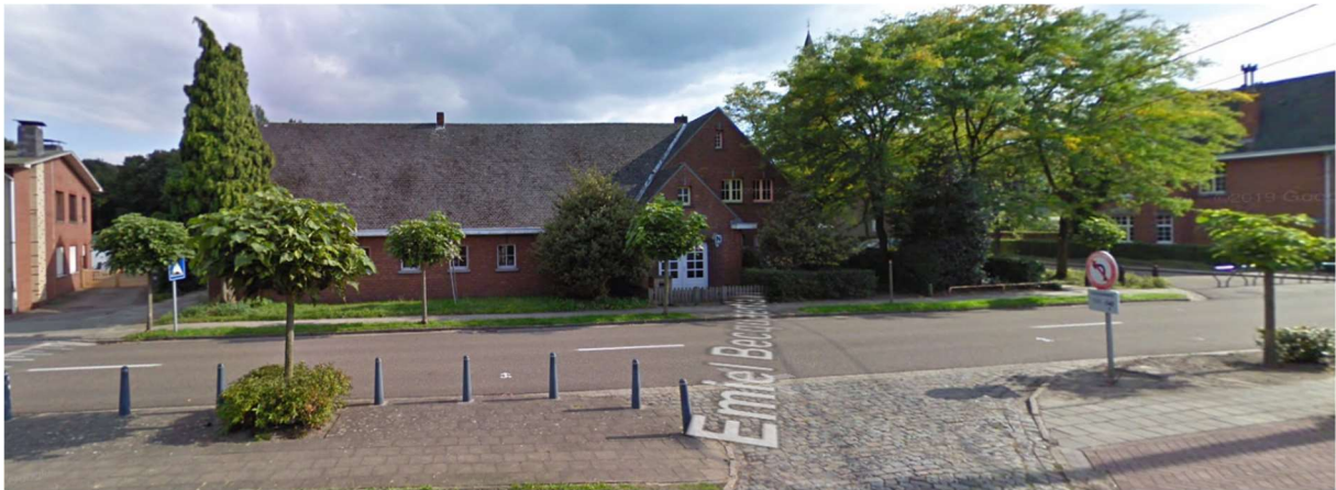
Figuur 3. Zicht op gebouw 1. © Google Streetview
