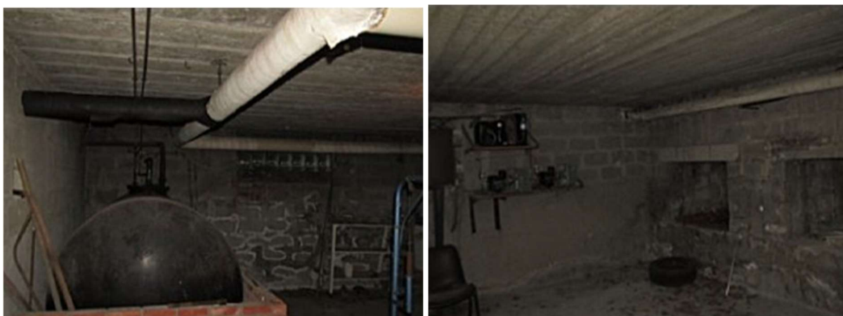
Figuur 7. Impressie van de kelder van gebouw 3.
