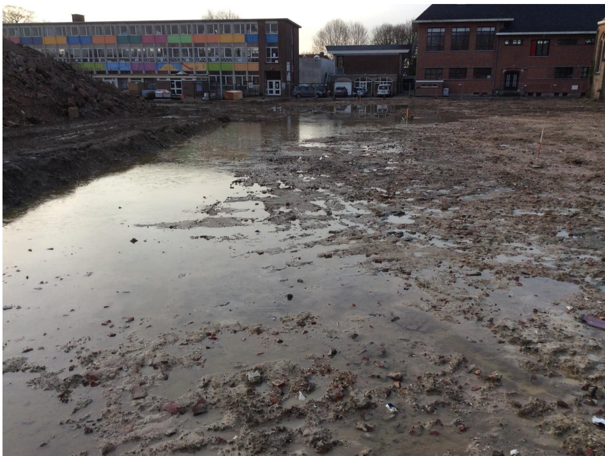
Figuur 2: Zicht op het terrein voor aanvang van de prospectie (zuidoosten).
