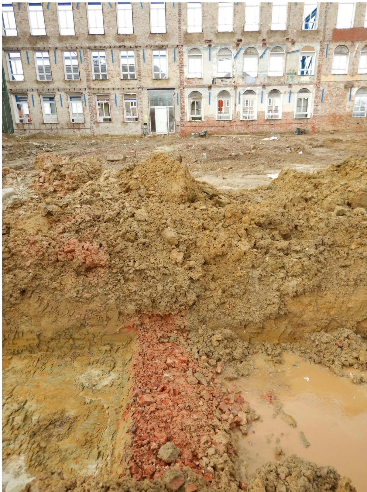
Figuur 18: Spoor 1 is een puinpakket dat de basis vormde van een fundering. Op de achtergrond de bewaarde voorgevel.
