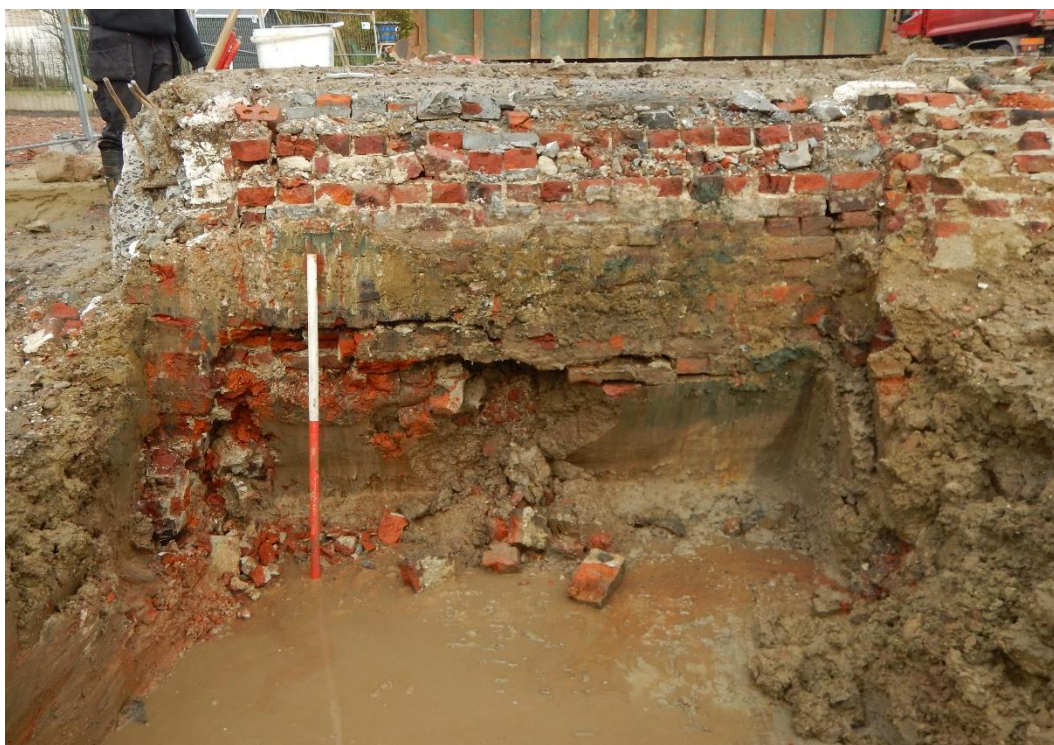
Figuur 5: Gemetste zijkant van de betonplaat.
