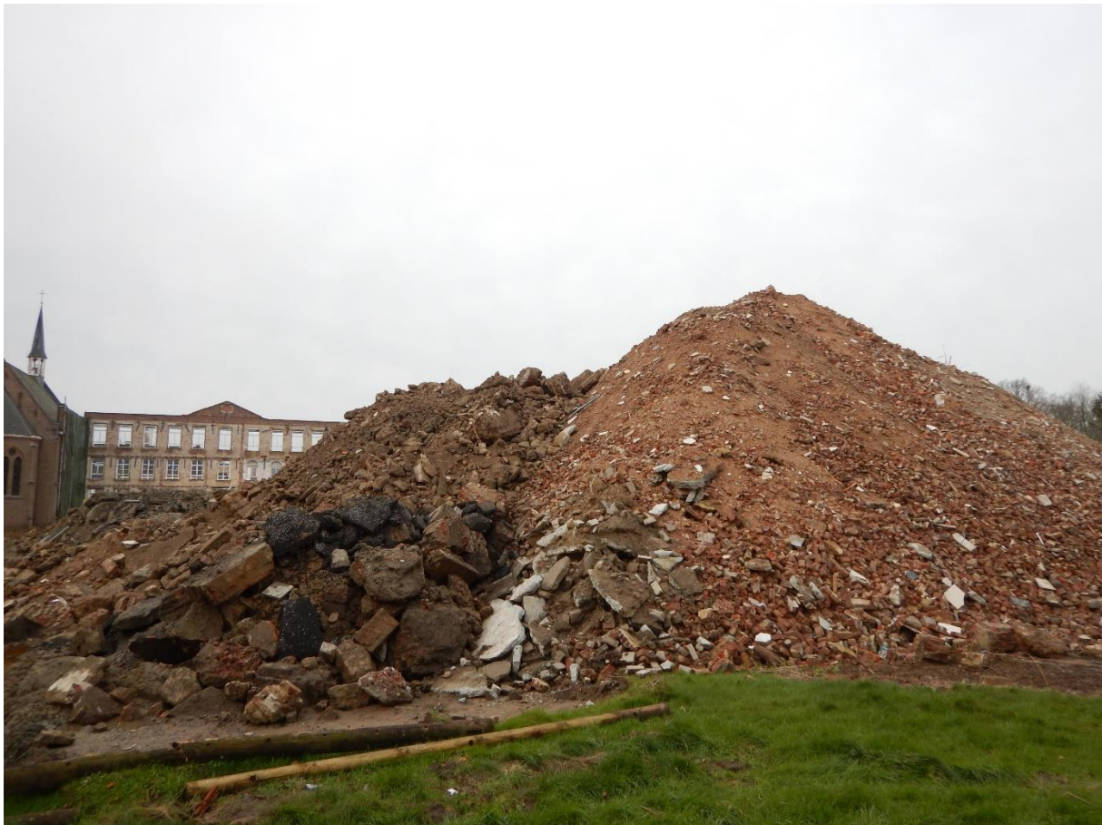
Figuur 9: Puin afkomstig van de gesloopte gebouwen en verhardingen aan de oostzijde van het terrein..
