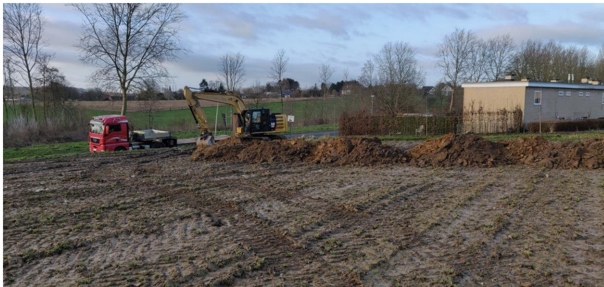
Fig. 1.1. Dilbeek - Lostraat. Sfeerfoto aanleg werkput 1
