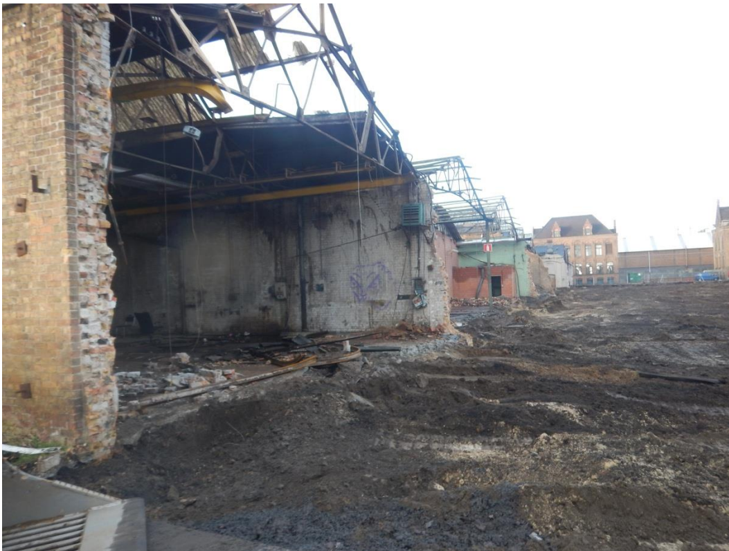
Figuur 12: Zuidelijke grens van het onderzoeksgebied, met de gedeeltelijk afgebroken bebouwing.
