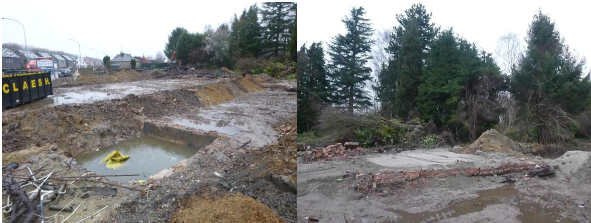
Figuur 14: Aanwezige kelder (links) en muurwerk, betonplaat en beplanting (rechts)
