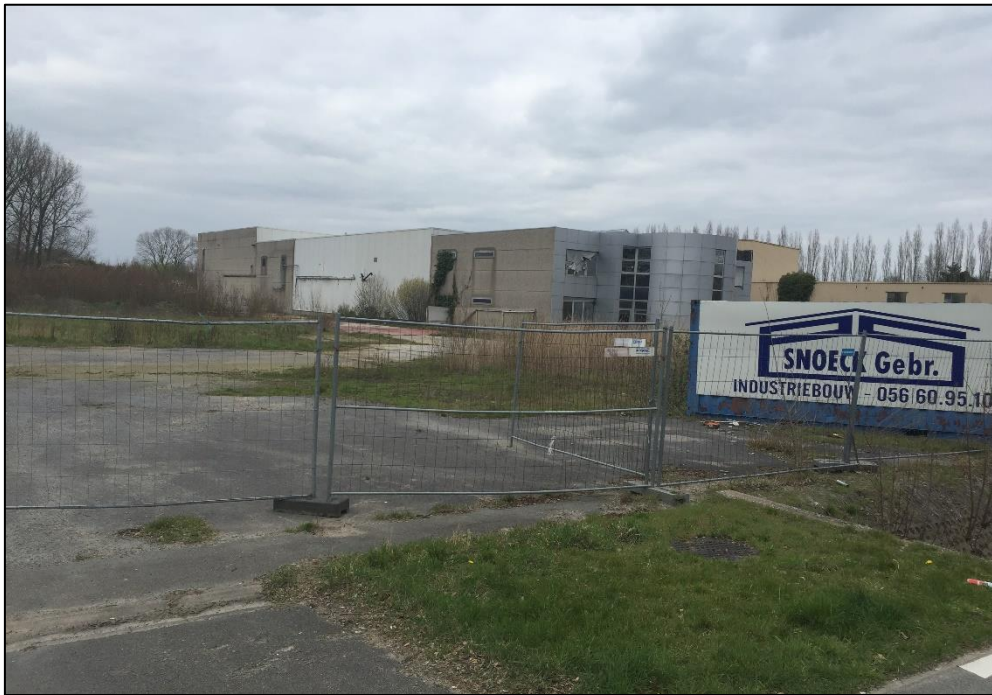
Figuur 4: Het fabrieksgebouw gezien vanaf het zuidwesten (Initiatiefnemer 2020)
