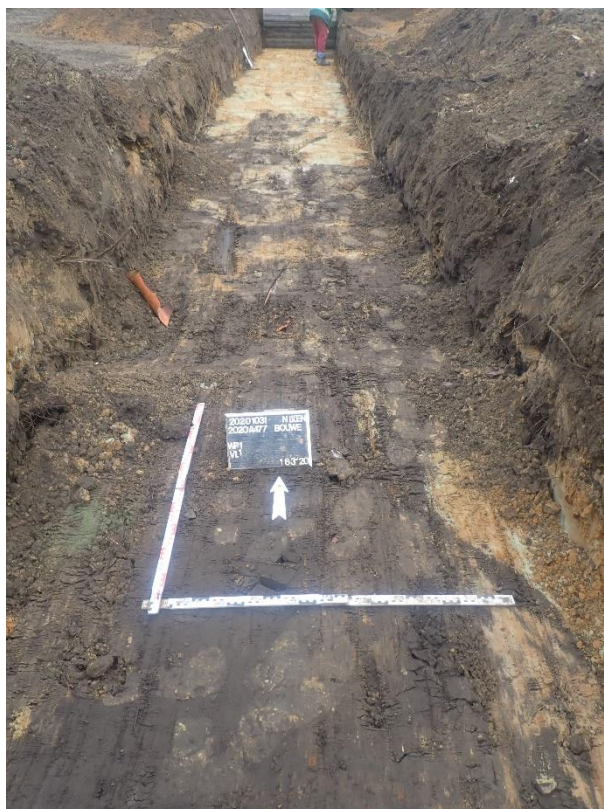
Figuur 22: Zicht op versterking in werkput 1: detail 2 (© J. Verrijckt Bvba)
