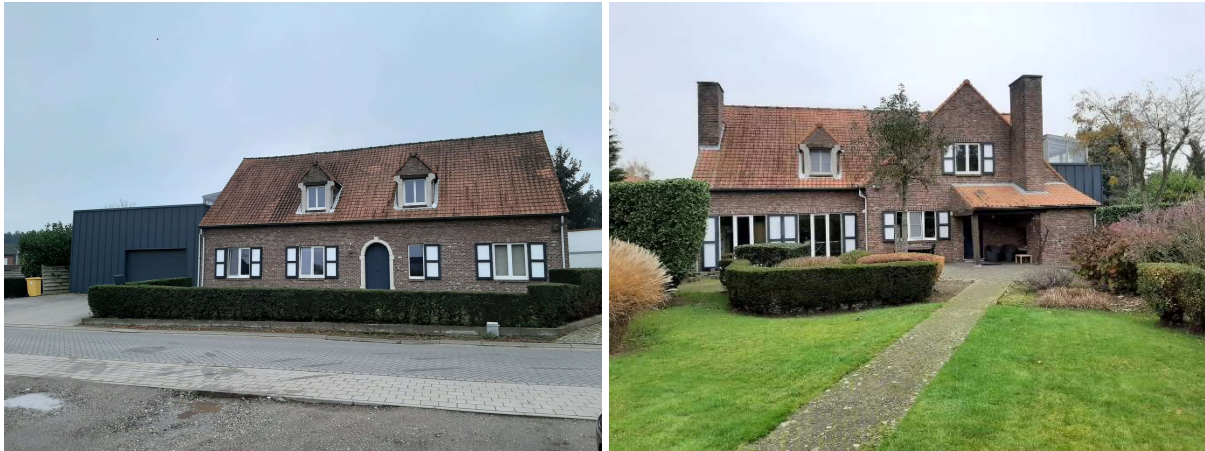
Figuur 3. Zicht op de bestaande woning op perceel 326R2. ©LARES
