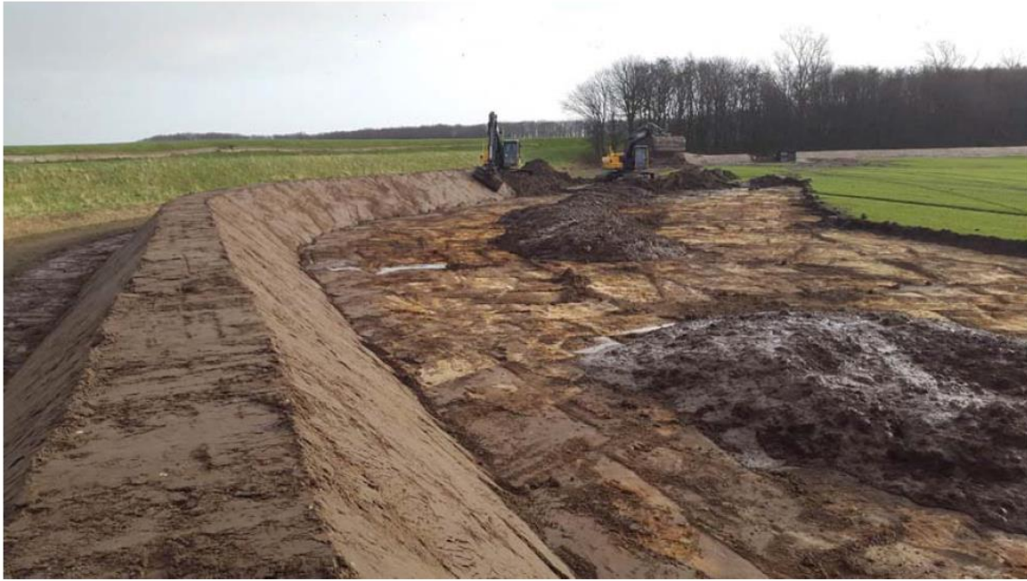
Figuur 9 Voorbeeld van het aanleg van een slibdepot met dammen (bron: initiatiefnemer)
