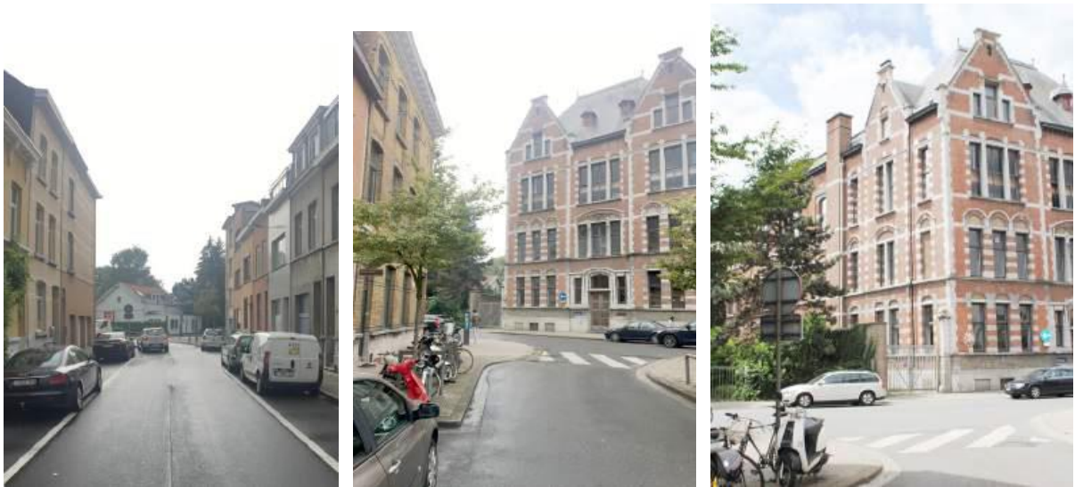
Figuur 7: Omgevingsfoto's: Zicht vanuit Politeshofstraat; telefooncentrale vanuit de De Beuckerstraat; zijgevel telefooncentrale (AG Vespa, 2020)
