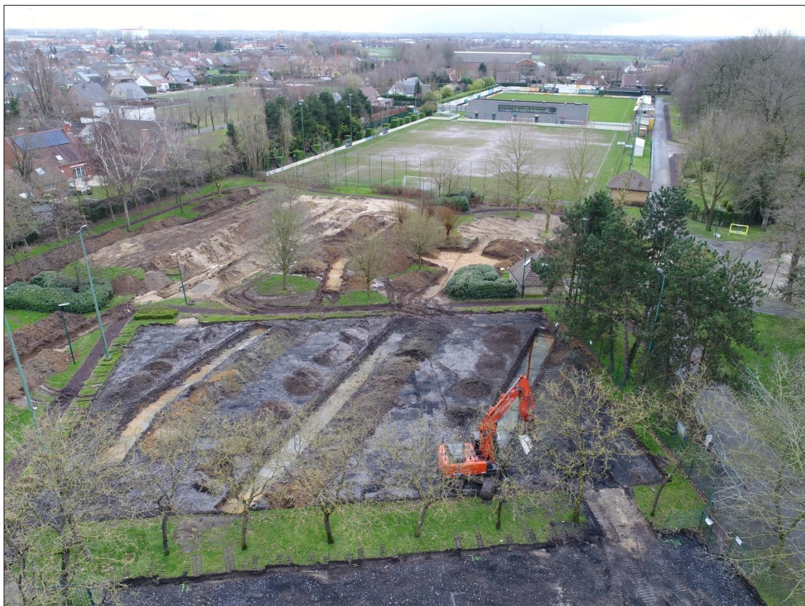
Figuur 43: Drone-opname van het projectterrein tijdens het proefsleuvenonderzoek vanuit westelijke hoek.
