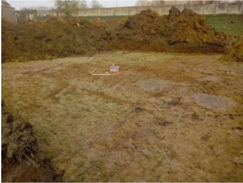
Figuur 12. Overzichtsfoto's sleuven en kijkvensters
