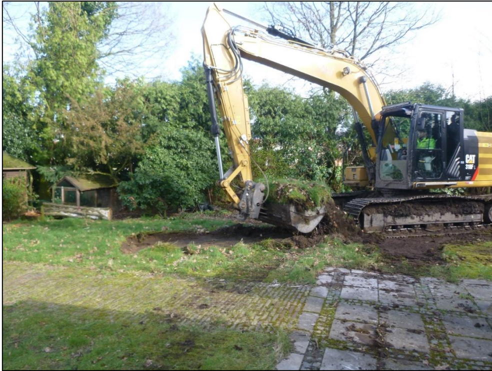
Figuur 20: Foto's methodiek: sleuven aanleggen met de kraan
