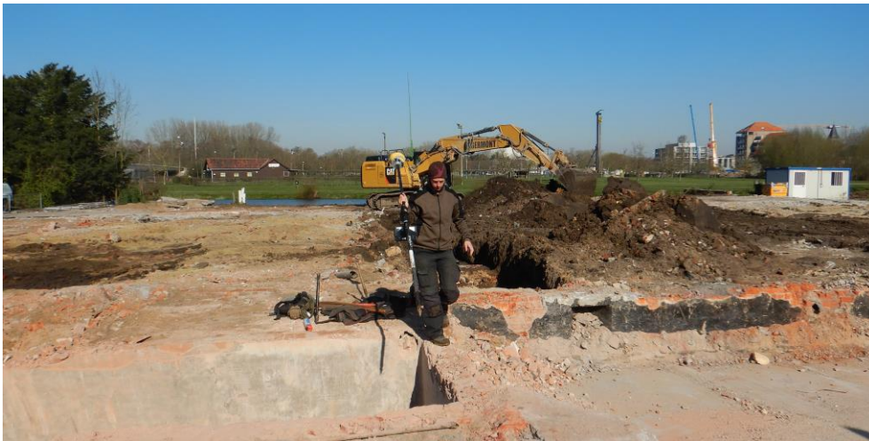
Figuur 22. Sfeerbeelden tijdens het aanleggen van de proefsleuven.
