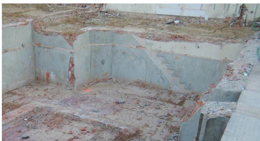
Figuur 10. De kelder van huisnummer 57, voor en na de sloopwerken.
