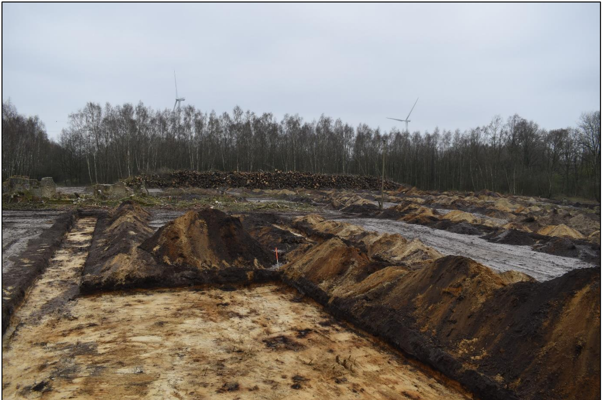
Afb. 40: Overzichtsfoto met vooraan KV3 (SL1) en achteraan de ruïne en kelders waarvoor sleuven 1, 2 en 3 onderbroken werden. Deze foto werd genomen vanuit het noordwesten (Bron: Aron bvba, dd 20/03/2020, 2020C306).
