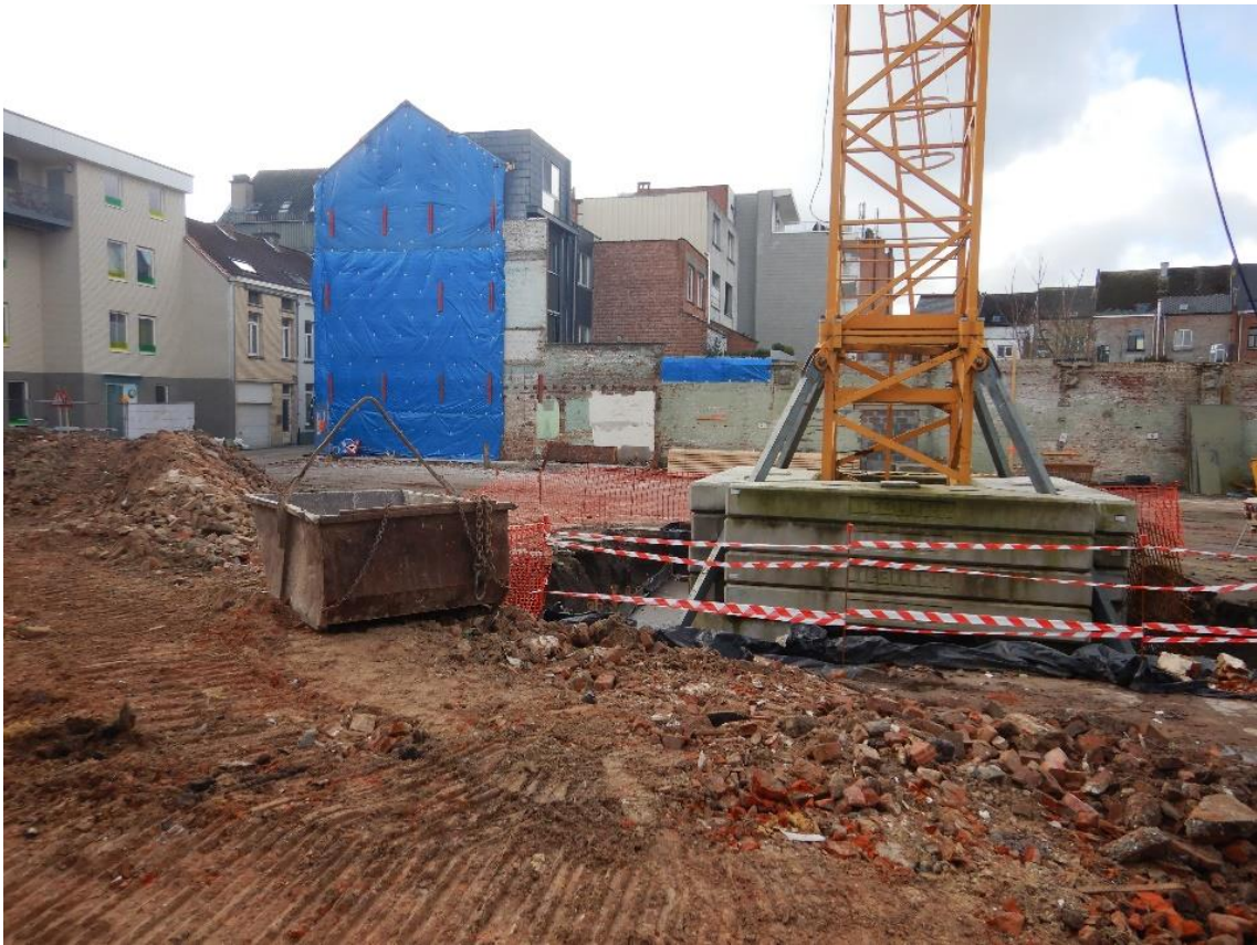
Figuur 9: Terreinsituatie met geplaatste torenkraan binnen de grenzen van het onderzoeksgebied.
