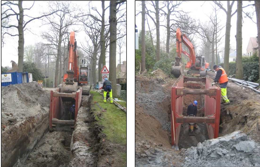
Figuur 5: Voorbeeld van het gebruik van een sleuvenbak wanneer de diepte voor de aanleg groter is dan 2m. (Bron: opdrachtgever 2016)
