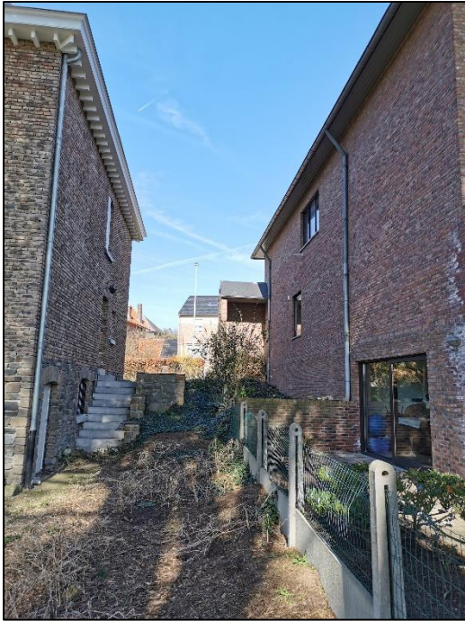
Afb. 33: Een trap overbruggt het hoogteverschil in het oosten van de villa (foto architect, 17/03/2020).
