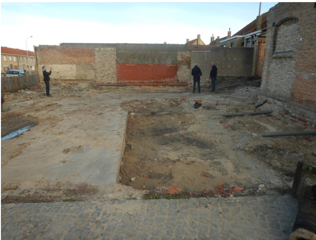
Figuur 18 Locatie van werkput 3 met aan de rechterzijde de riolering die moest behouden blijven. (bron: Ruben Willaert bvba)
