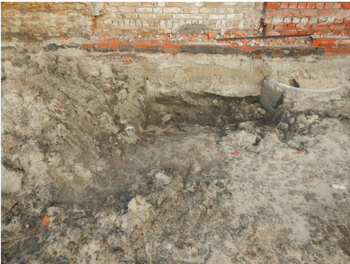
Figuur 71 Foto van een paalfundering van de brandweerkazerne (rechtsboven)
