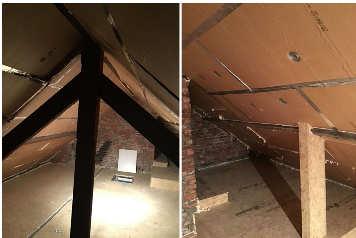
Figuur 6. Zicht op het dakgebinte van de woning Patersstraat 113.
