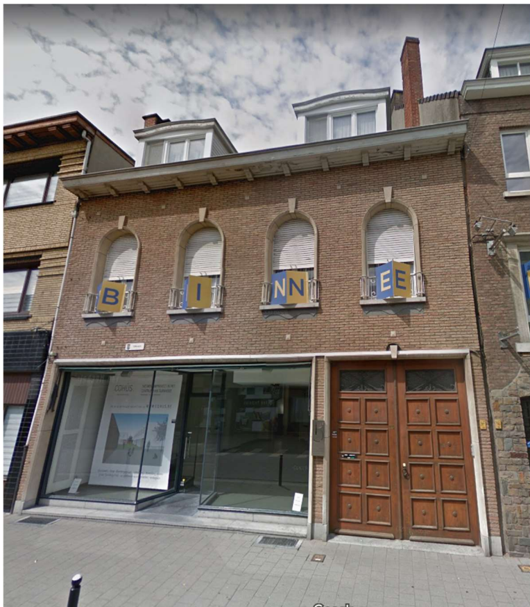
Figuur 4. Zicht op woning Patersstraat 113. ©gOOGL E STREETVIEW
