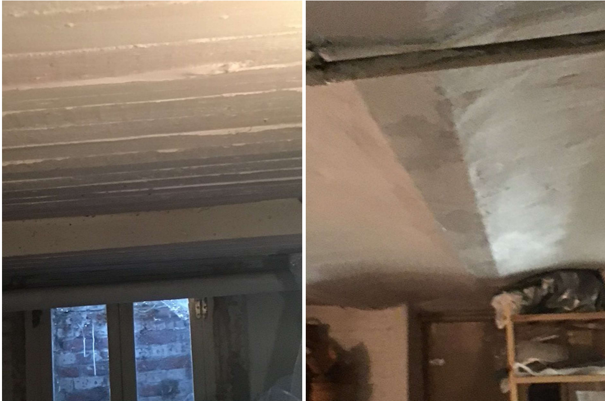
Figuur 7. Zicht op keldergewelf woning Patersstraat 113.
