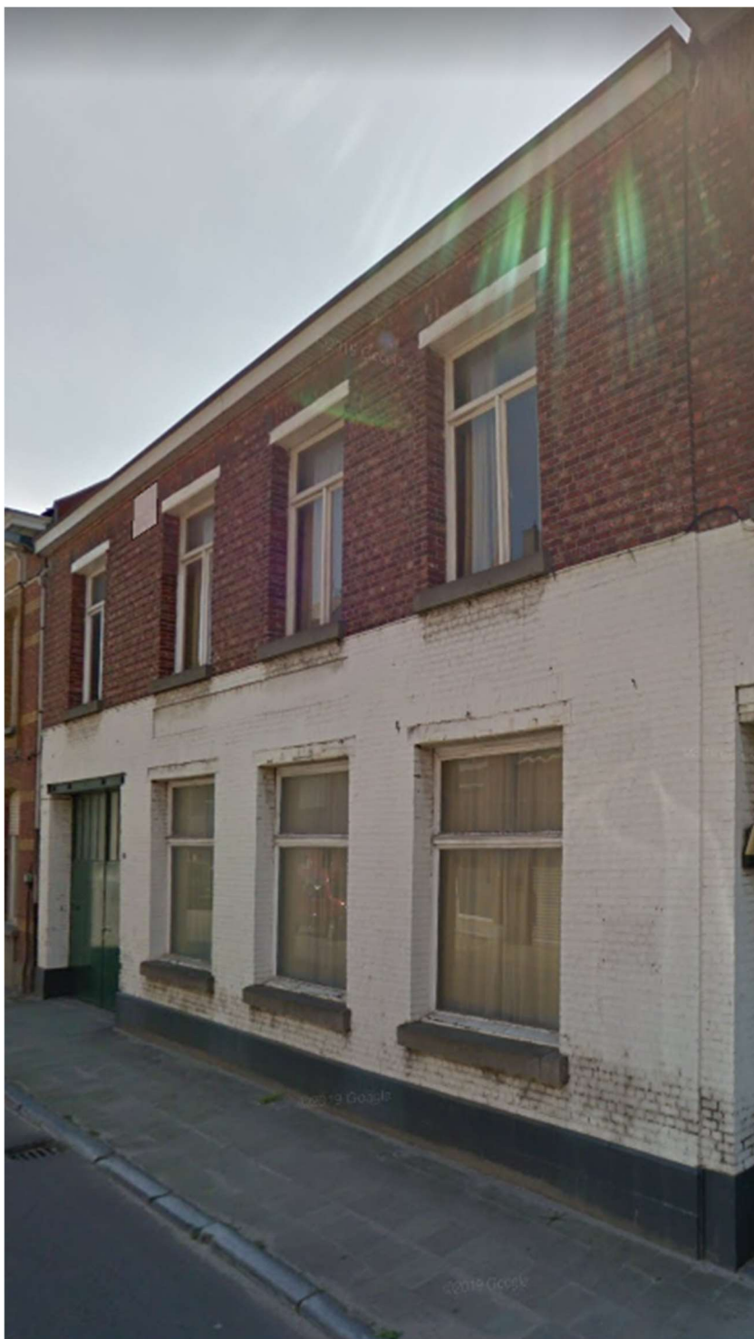
Figuur 17. Zicht op woning Koning Albertstraat 13. © Google Streetview
