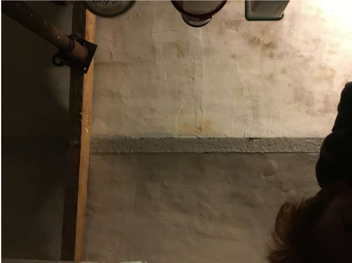
Figuur 15. Zicht op het kelderplafond van woning Patersstraat 121.
