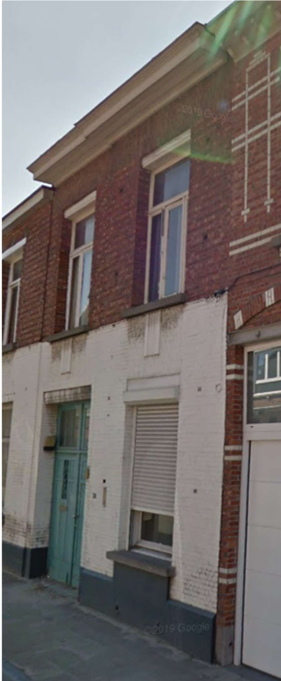
Figuur 18. Zicht op woning Koning Albertstraat 15. © Google Streetview
