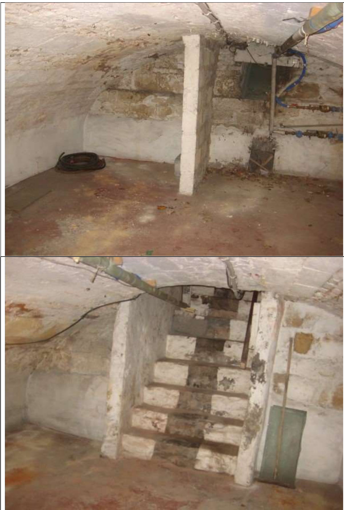
Figuur 7. Toestand van de bestaande oostelijke kelder.
